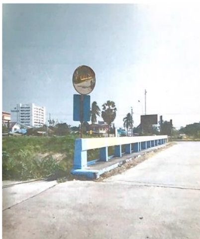
ถนนเลียบคลองชลประทาน สะพาน ๑
